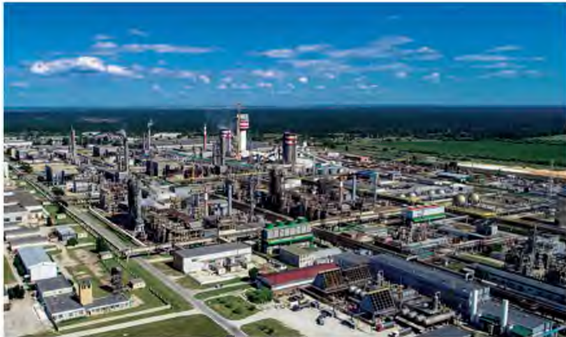
Новая структура производственного блока отражает единство целей и задач для производственной площадки
