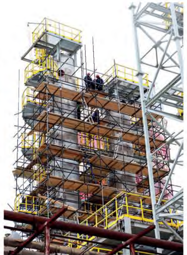
Сегодня на площадке работают около 1000 строителей
